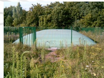
Récupération d'eau de pluie
