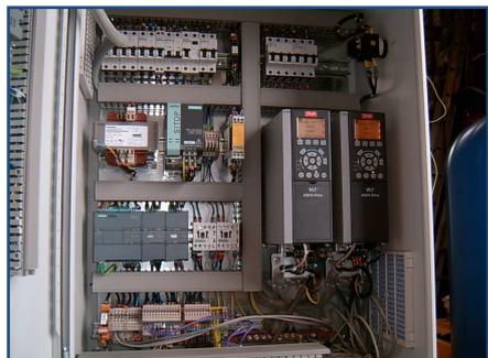
Le module **ATLANTE 5** est automatisé afin de réduire au maximum toute opération pour le personnel exploitant. Fixé sur le châssis du module, le coffret regroupe l'ensemble des commandes de régulation de la station, ainsi que les protections des circuits de puissance en conformité avec la norme NF C15100.
