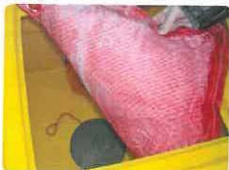
Le coussin absorbant qui capture les hydrocarbures au fond de la cuve.
